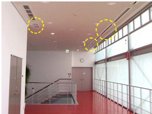
増設された天井埋込型のファンコイル
