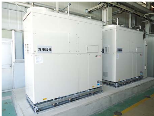
ガスコージェネレーション設備
