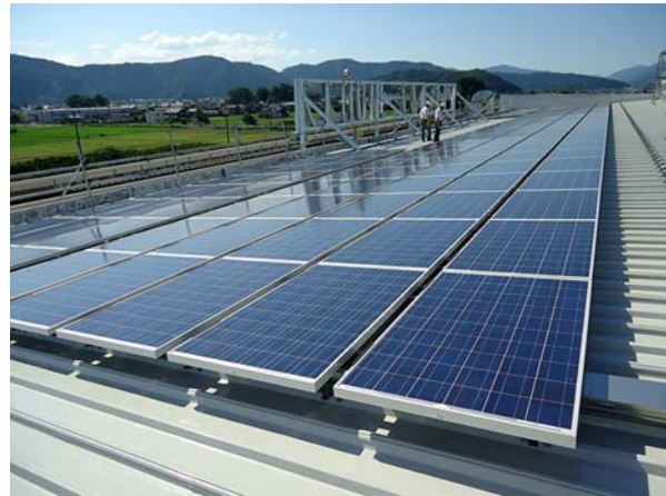
工場の屋根に設置された太陽光パネル
