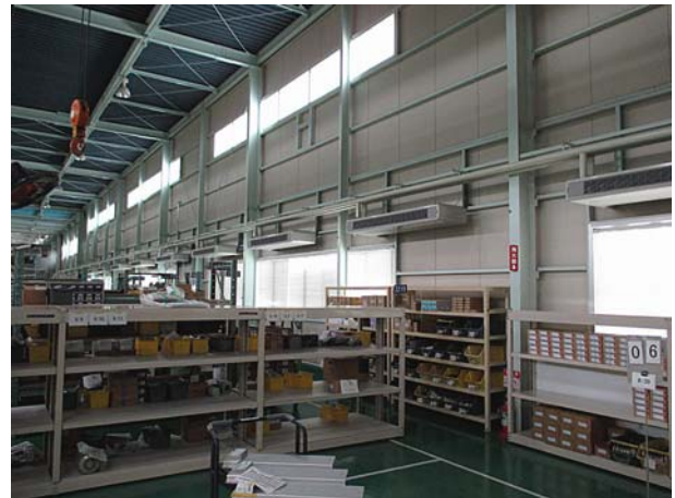
製品組立工場のファンコイル
