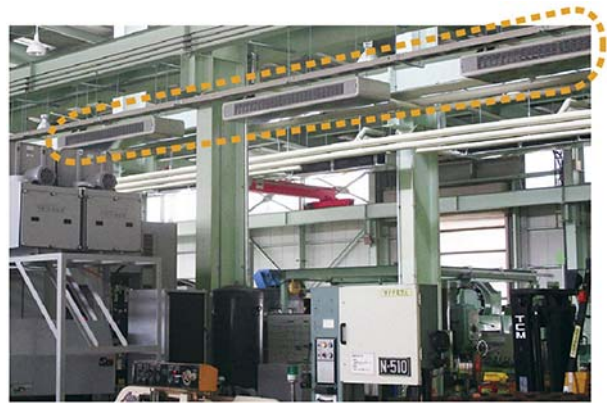
機械加工工場に設置されたファンコイルユニット
